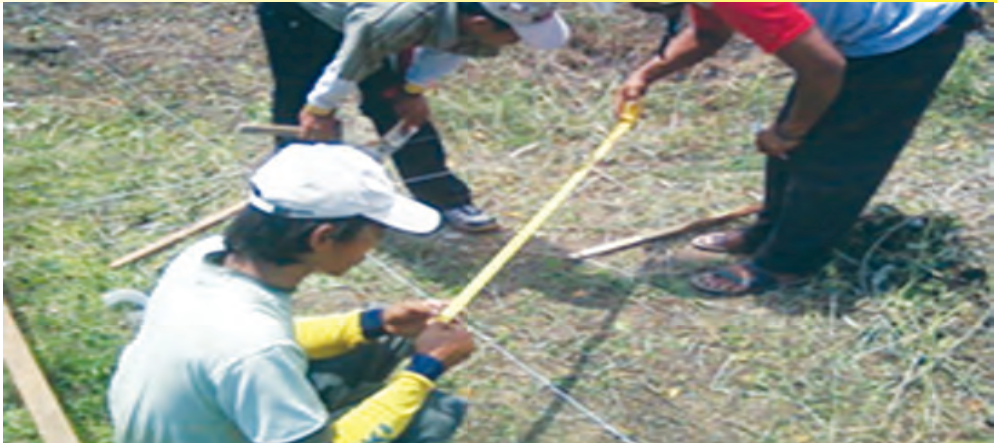
Gambar 6.1 Seorang Tukang sedang mengukur kesikuan lahan
